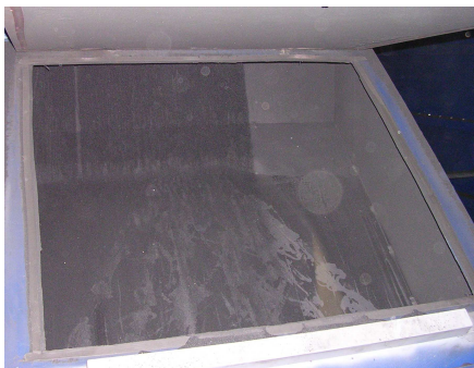
Sanddurchlauf im Kaskadensichter
